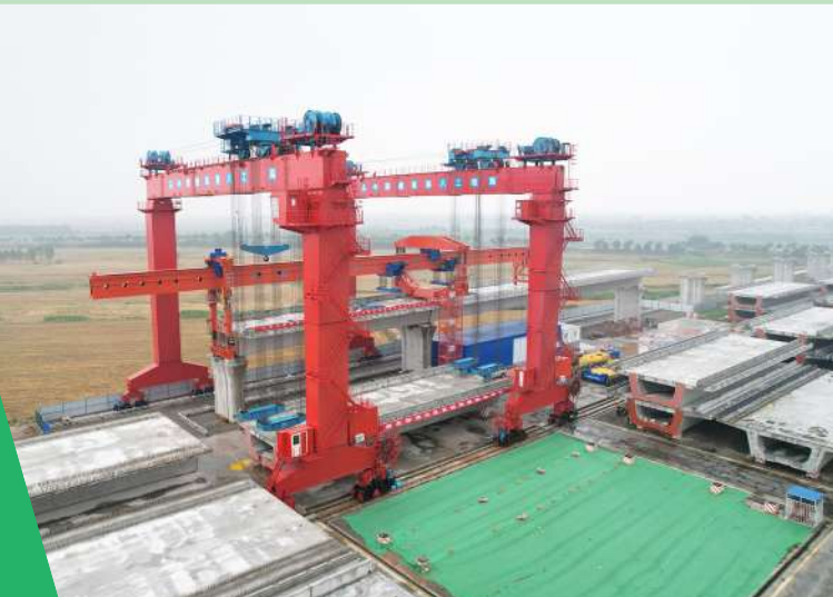
津潍高铁滨州段首幅箱梁成功架设。
