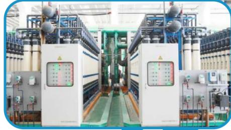
得了重大突破。该项目充分利用大唐电厂海水冷却带余温的海水作为原水,降低了能耗及制水成本,在成本控制方面已达到世界一流水平。项目采用碧水源自主研发生产的具备完全自主知识产权的双膜法海水淡化工艺(超滤膜、反渗透
