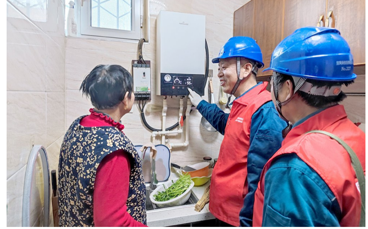
近日,在阳信县翟王镇西小吴村,电力公司服务人员上门走访“电采暖”客户,帮助客户检查家中用电设备,宣传冬季取暖安全用电知识。2023年以来,国网阳信县供电公司各专业人员协同发力,切实保障为客户提供优质、安全的用电保障。(滨州日报/滨州网通讯员 马闯 摄影)
