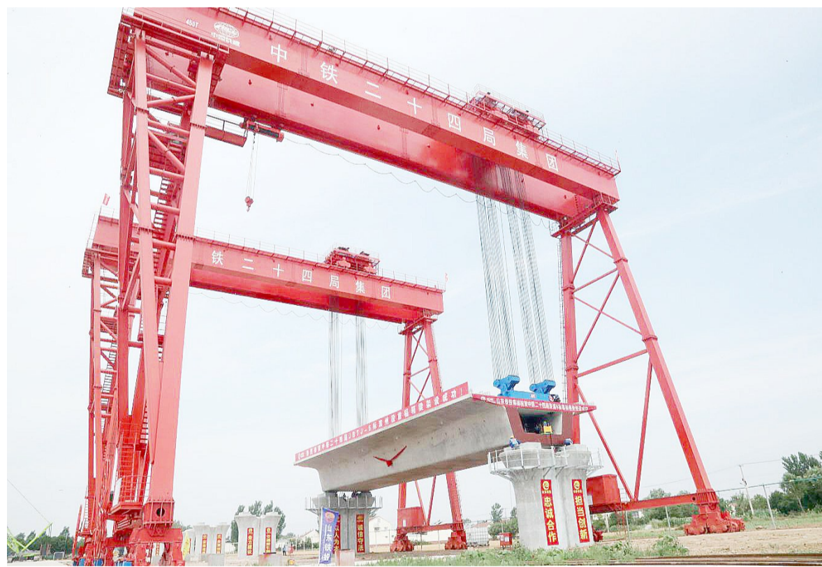
顺利。市交通运输局将盯靠高铁项目建设全过程,及时掌握项目最新进展和遇到的困难问题,帮助项目建设单位、施工单位打造一流施工环境,全力保障滨州高铁建设快速推进。
