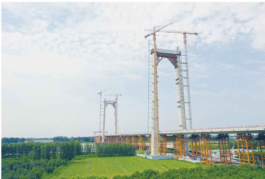
黄河特大桥是沾临项目重点控制性工程,由中交一公局集团承建,全长4630米,主桥长962米,为双塔双索面钢混组合梁斜拉桥,主跨442米,是目前黄河下游跨径最大的桥梁,主梁顶推重量超27000吨,开创黄河下游组合梁斜拉桥顶推施工之最,主梁采用UHPCC无粗骨料超高性能混凝土预制桥面板设计在国内尚属首次。
