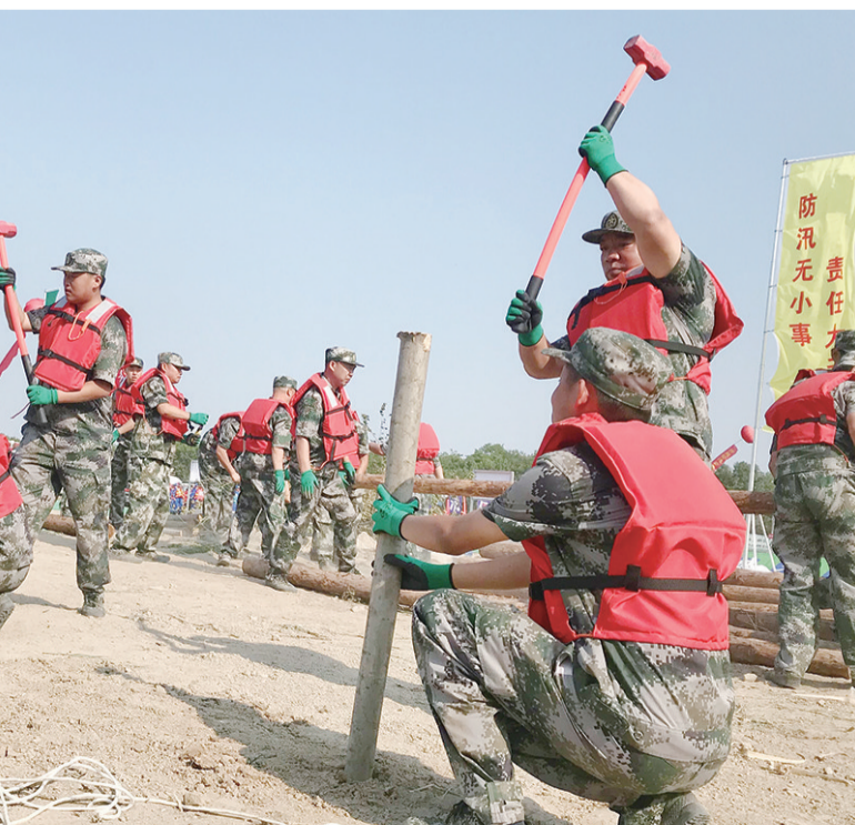
抛投柳石枕打桩固堤。
