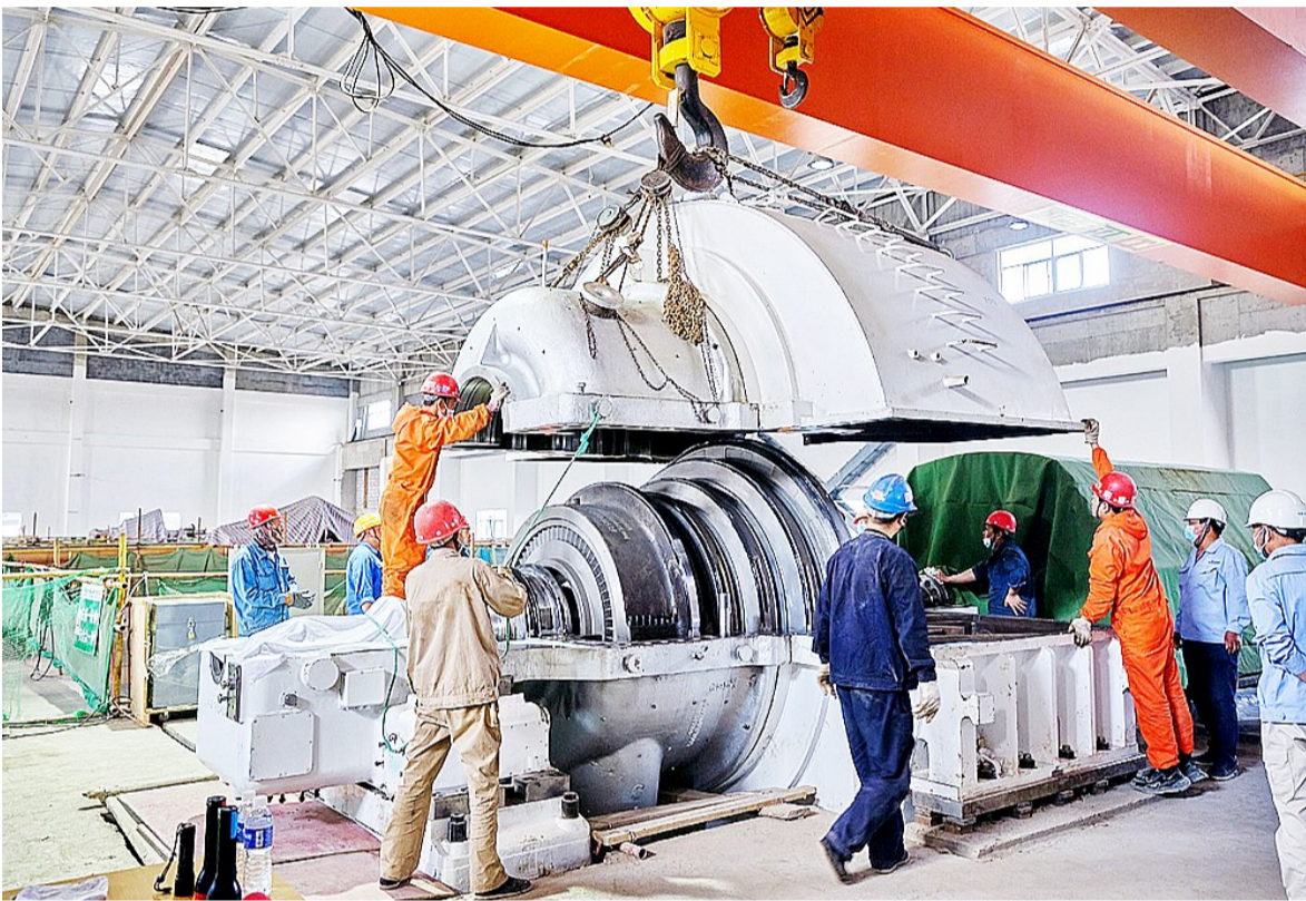
三碳四综合利用项目按期投产,在更高质量、更具活力的现代化
