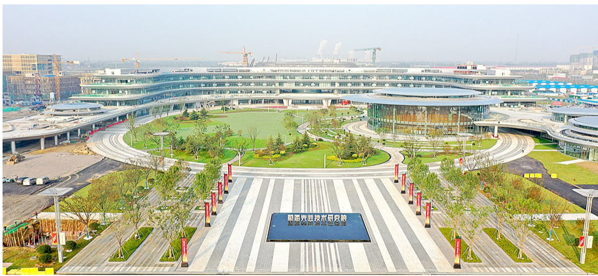
图为即将竣工的渤海先进技术研究院一期工程。(张雅杰 摄影)
