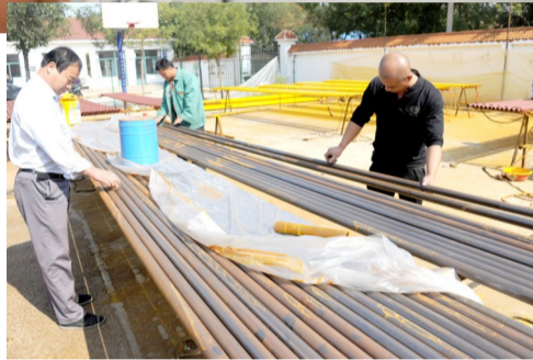
燃气管线、燃气表、暖气片等原材料已经准备就绪,将在10月20日前全部安装完毕。
