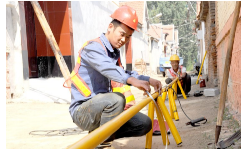
施工人员正在安装燃气管道,将燃气送进每家每户。
