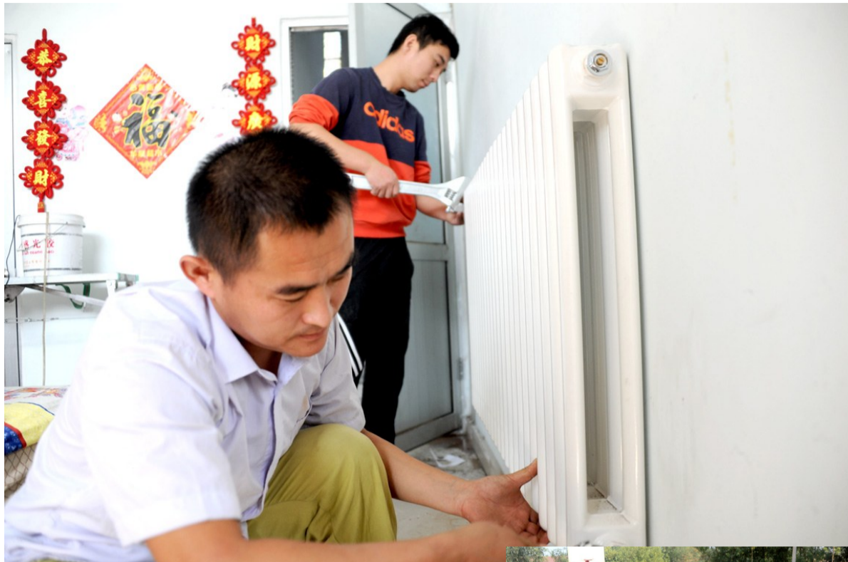
在王素先村,已有80多户村民家中完成暖气片、燃气管线安装。
