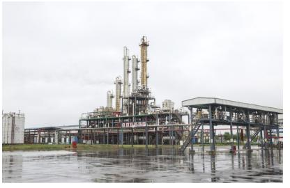
动能培育成长,沾化瑜凯新材料科技 有限公司从2016年至今已陆续投资 5.3亿元,对原有歧化法新戊二醇装置 进行技术改造,产品品质达到国际-流水平, 电耗降低11%、水耗降低5%, 成本节约20%,产品回收率提高15%, 更环保、更安全,并推动产品向精细 化、高端化方向发展。
